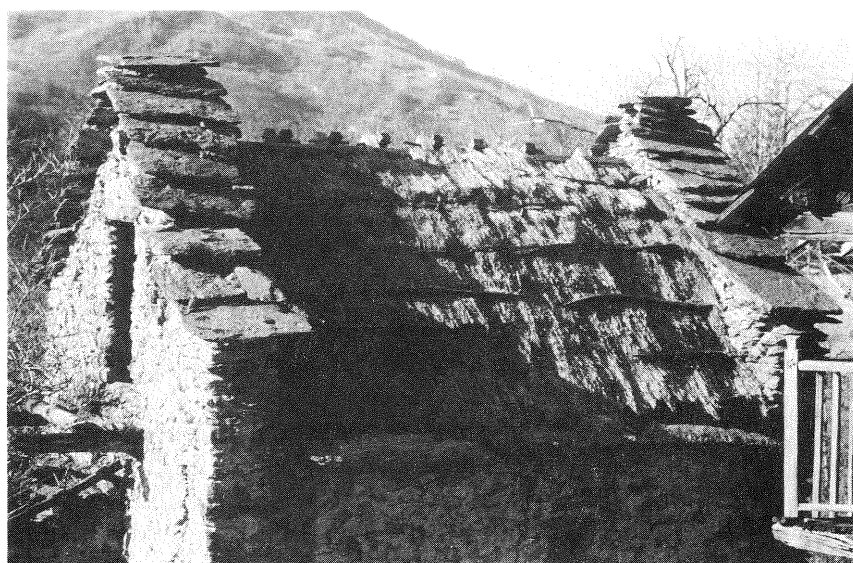
Fig. 1 - Val Corsaglia, loc. Pra (m. 1000 circa, com. Frabosa Soprana - CN). Tetto in paglia racchiuso tra i frontespizi salienti.
