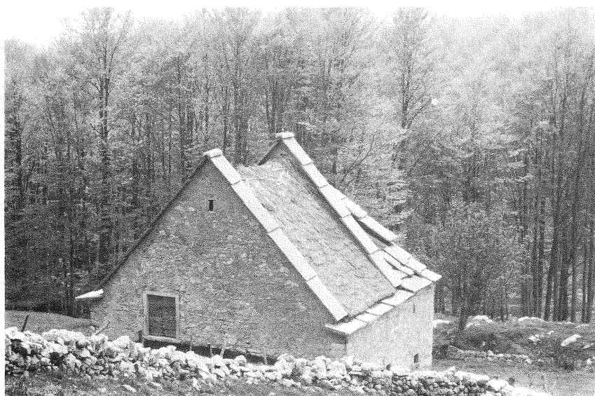
Fig. 4 - Loc. Lobbia Bassa (m 1280, com. Selva di Progno, VR). Tetto racchiuso con inclinazione del manto di paglia intorno ai 50^\circ . La pendenza cambia in corrispondenza delle laste disposte sul muro.
