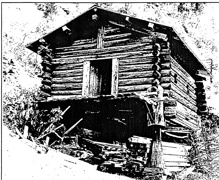
Stipiti di sostegno tirolesi con difesa dai topi... una tipica costruzione nelle Alpi.
