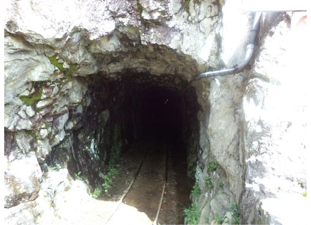
L'ingresso di una delle gallerie del Tracciolino realizzata negli anni '30 con il binario a scartamento ridotto ancora oggi utilizzato per la manutenzione del bacino d'acqua per la produzione di energia elettrica;
